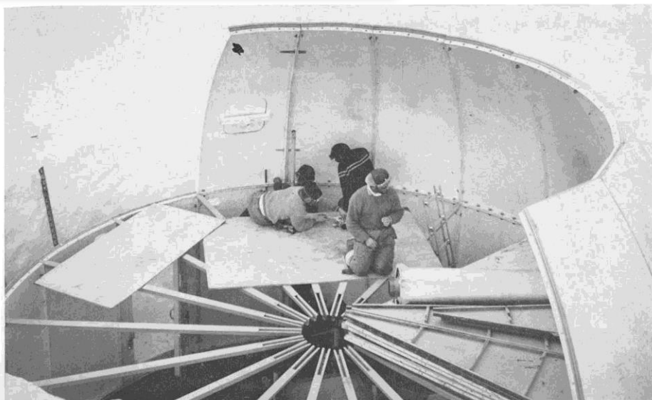
Station Jarl-Joset blev konstrueret som en rund plastic-kuppel i 2 etager.
