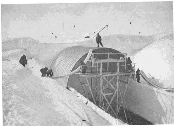
Overdækning med bølgeblisksplader af en af gangene i Camp Century.
